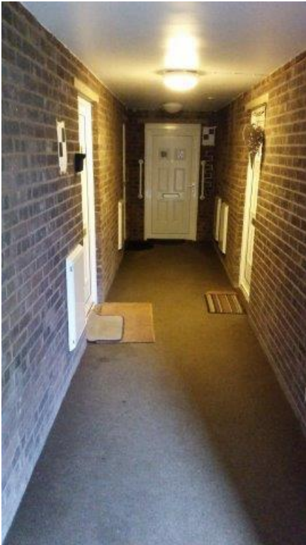
▲ F.47 Non fire doors used internally
